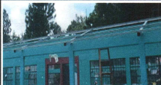
Foto 2: Armando estructura de soporte de metal
