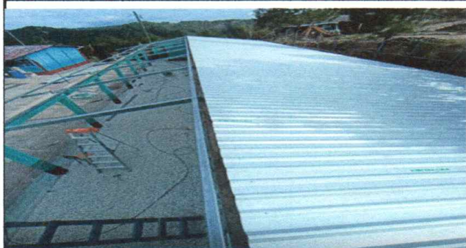
Foto 1: Instalando techo de lámina
