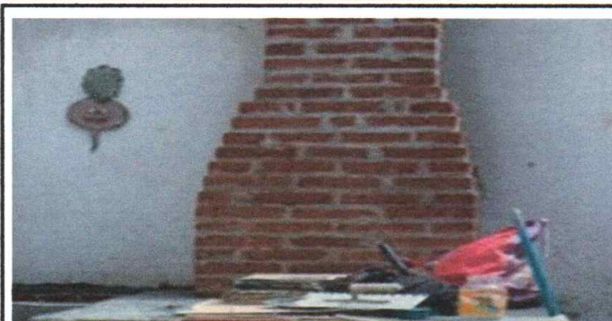
Foto 6: Construyendo chimenea de ladrillo
