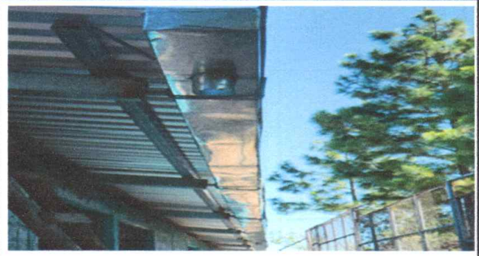
Foto 2: Instalando canales y bajadas de agua pluvial
