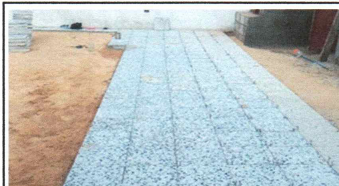
Foto 3: Colocando piso de cocina
